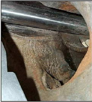
図6 原子炉容器上蓋に見つかった腐食劣化の状況(写真)
